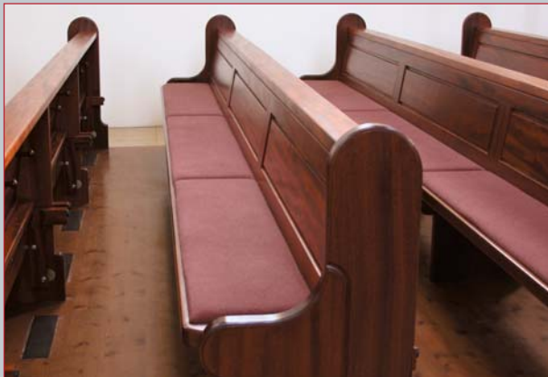
Formgebung der Außenwangen in Anlehnung an die vorhandene Architektur.
